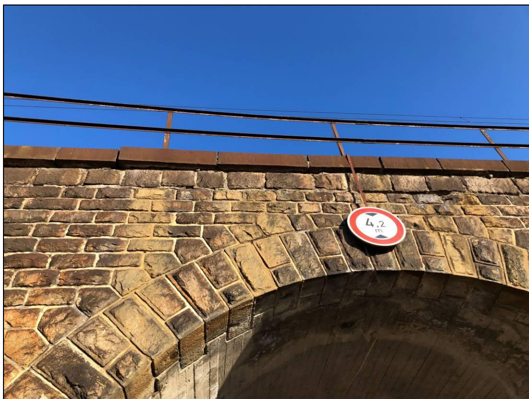
Obr. č. 13 – pohled na římsu s vychýlenými kamennými kvádry
