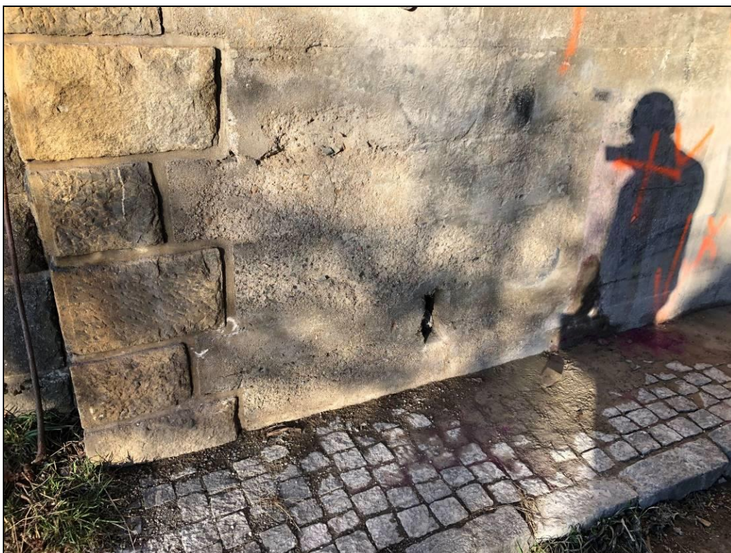
Obr. č. 15 – detailní pohled na opadanou krycí vrstvu betonu ve spodním lici opěry Křižanov
